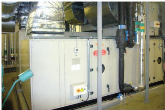
Рисунок 4 Система вентиляции действительно хорошо изолирована, но не имеет теплообменника для рекуперации тепла из отработанного воздуха.
